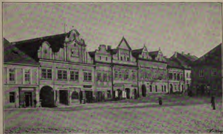
Štítové domy na jižní straně Velkého náměstí (nyní č. 87, 88, 89 a 90).
